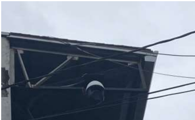
Imagen 1. Imagen de la estructura.
