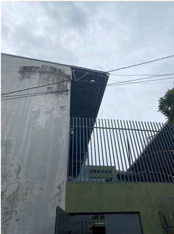
Imagen 2. Imagen de la ubicación de la estructura.
